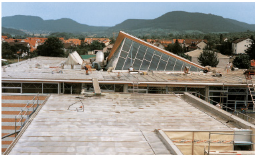
Hitsaamalla saumattu ruostumaton teräskatto ennen viheristutusta (oikealla) ja viheristutusten jälkeen (takana oikealla).
