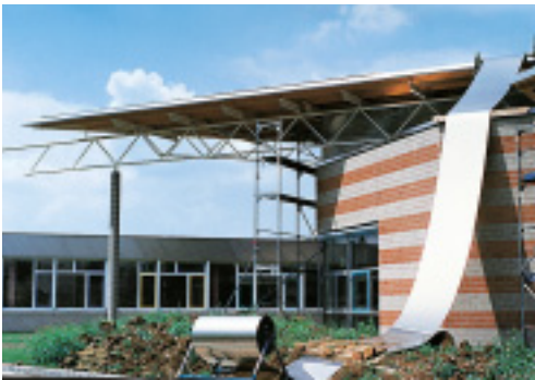
Ruostumaton teräs-ohutlevy katkaistaan määrättyihin mittoihin työmaalla.
